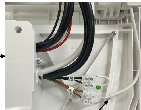
Cablul de comunicatie (comanda ON/OFF sau comunicatie OT in functie de modelul centralei)
